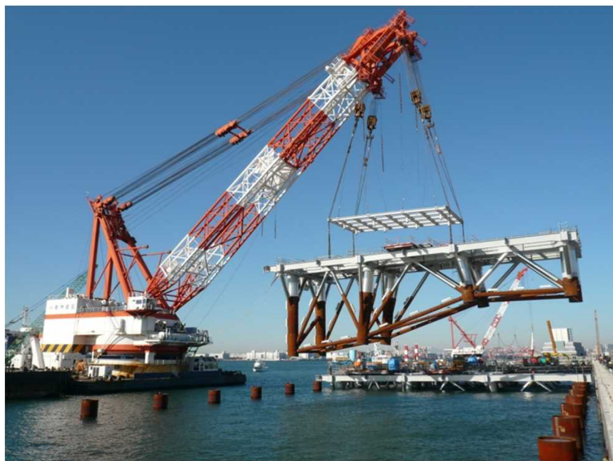
ジャケット据付状況 (Y2施工時)
