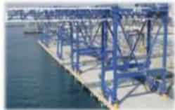
耐震強化岸壁・免震クレーン
